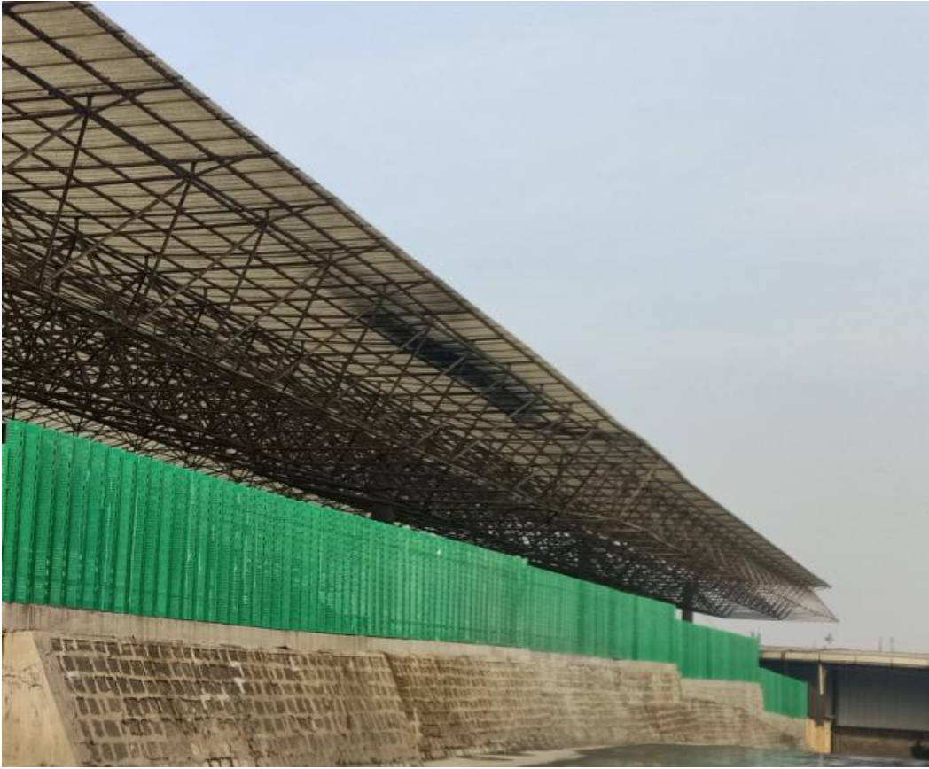
堆场围堰及防尘网
