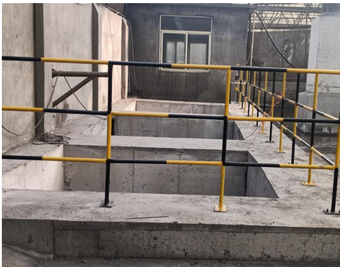
渗滤液收集池
