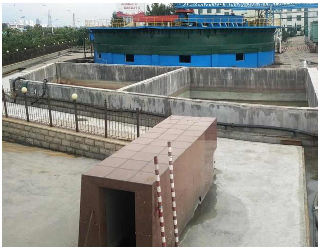
初期雨水收集池
