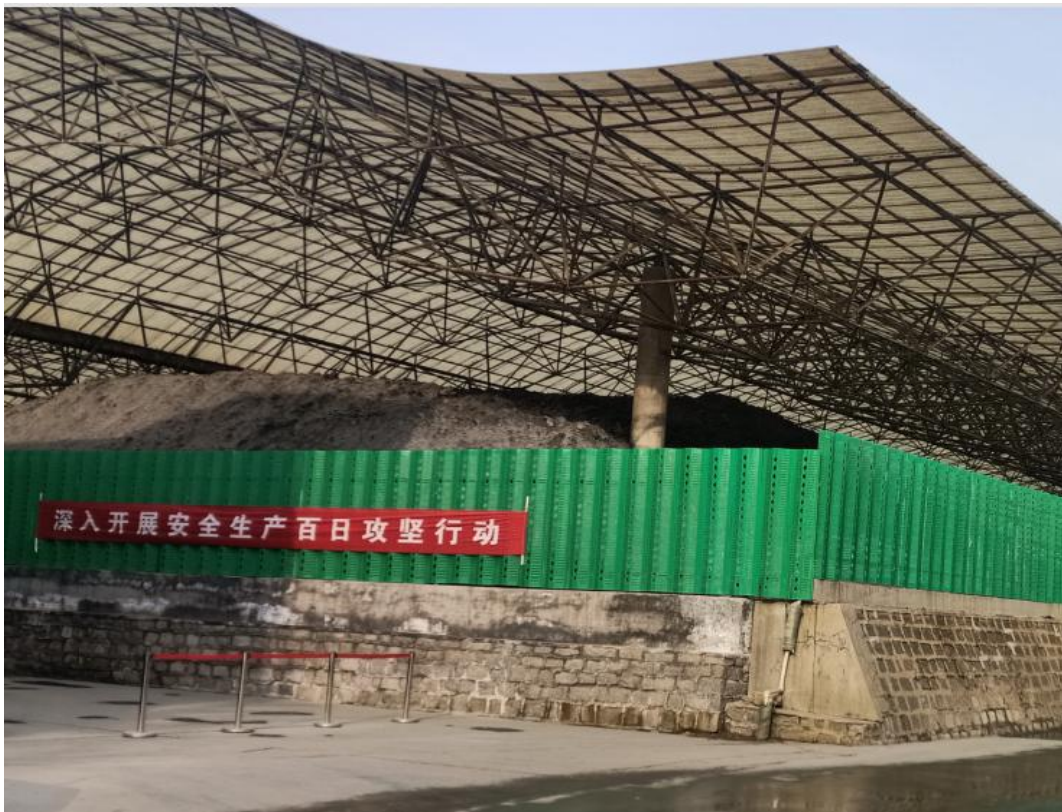
堆场围堰及防尘网
