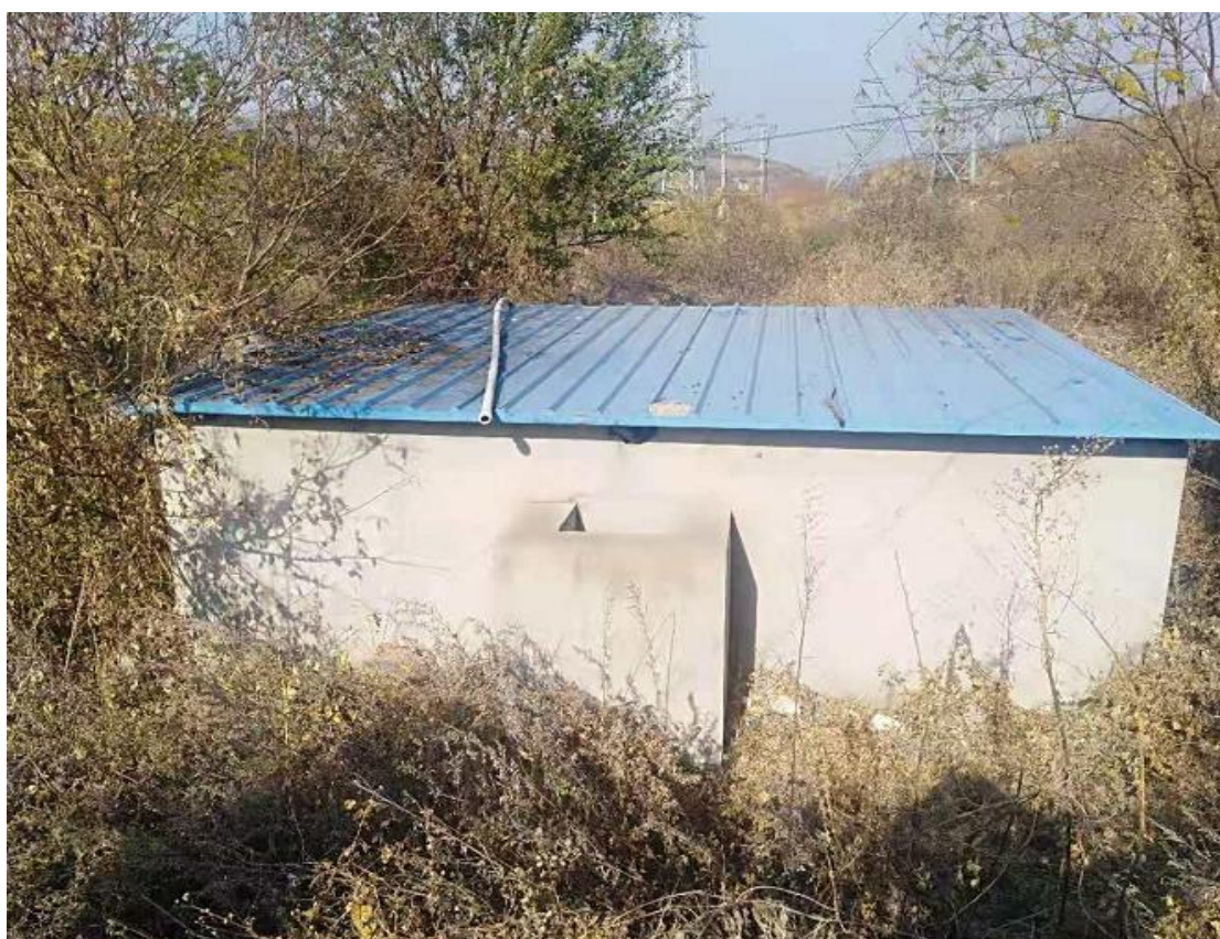
地理式污水处理站
