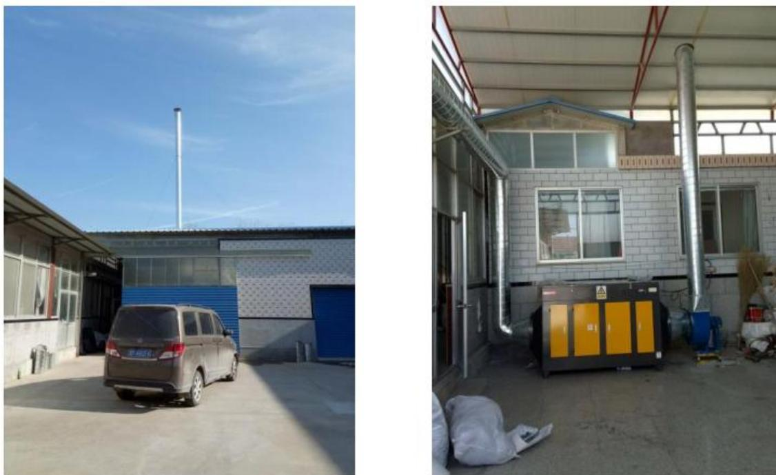
图 3-2 废气净化装置+排气筒
