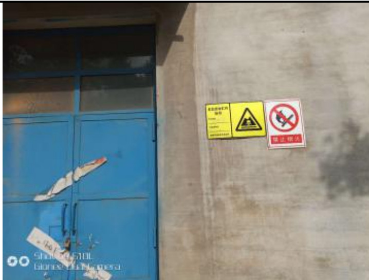
图 3-2 危废间标识牌
